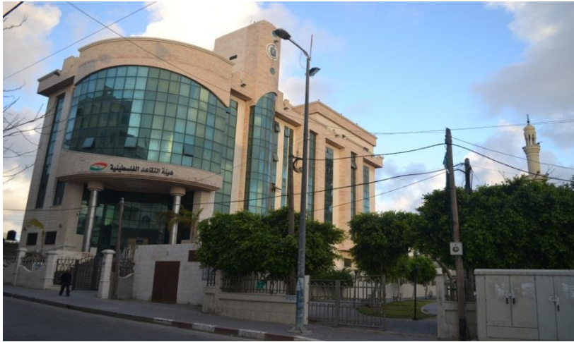
شكل (6-6) مبنى هيئة التقاعد الفلسطينية.
