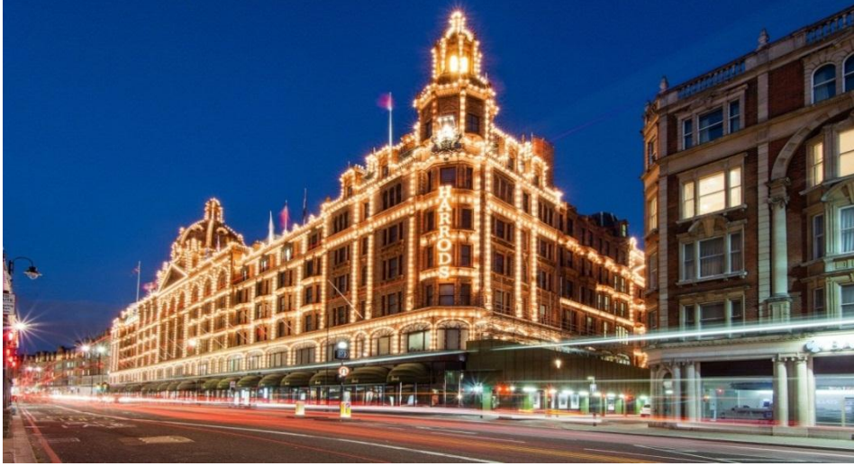
شكل (3-25) إضاءة حواف المبنى وإعادة رسم خطوطه بالإضاءة للجذب التجاري
